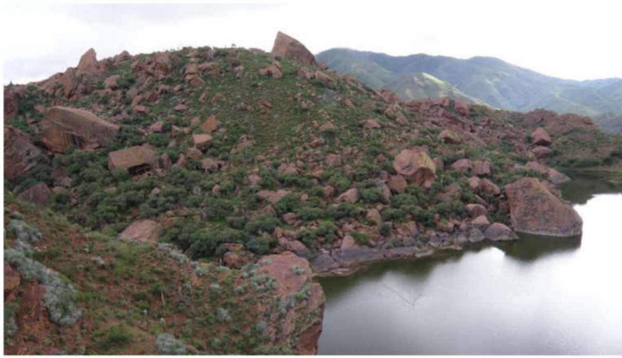
Figura 8B: Vista hacia el sudoeste del deslizamiento en la zona del cierre de la laguna.
