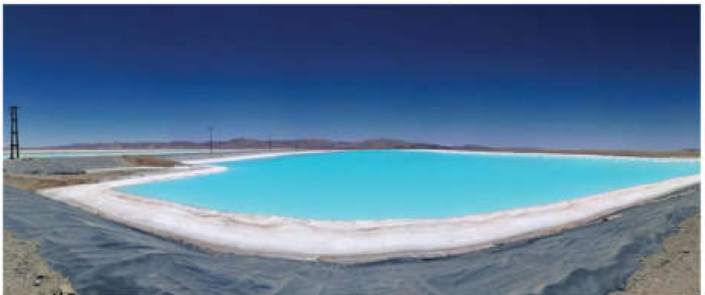
Figura 3. Poza de evaporación de salmuera para recuperación de litio en el salar de Olaroz.
