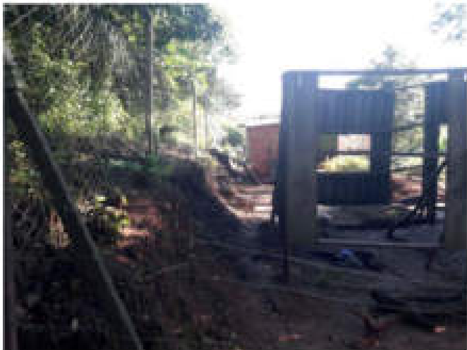
Figura 5. Vivienda colindante con vegetación en la localidad de Aguas Blancas.
