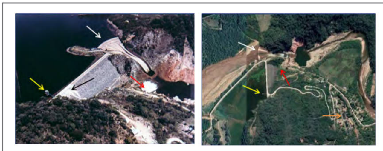
Figura 2. Izquierda: Vista hacia el NO de la presa en 1983, antes de su colmatación. Las flechas indican: el vertedero (blanca), la torre de toma (amarilla), la válvula de chorro hueco (roja) y la zona colapsada y reparada sobre el estribo derecho (negra). Derecha: Imagen actual de la presa, obtenida de Google Earth. Las flechas indican: el vertedero (blanca), la torre de toma (amarilla), la válvula de chorro hueco (roja) y la planta potabilizadora (ocre).
