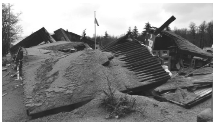
Figura 8. Techo colapsado por acumulación de ceniza. Paso Internacional Cardenal Samoré, Neuquén. Foto tomada el 8 de Junio de 2011 por Valeria Outes y Gustavo Villarosa.
