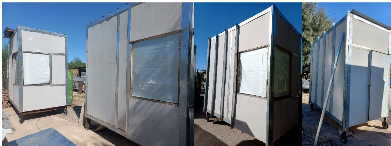
Fig. 2: Boxes en proceso de intervención
