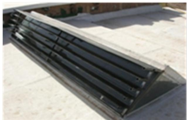
Fig. 1. Esquema e imágenes de sistema de calefacción radiante pasiva – SIRASOL-
