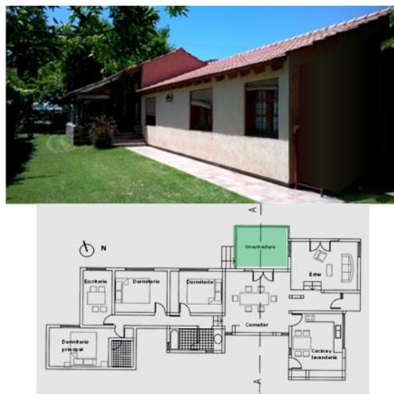
Fig. 2: caso 1, foto de la fachada N y planta.
