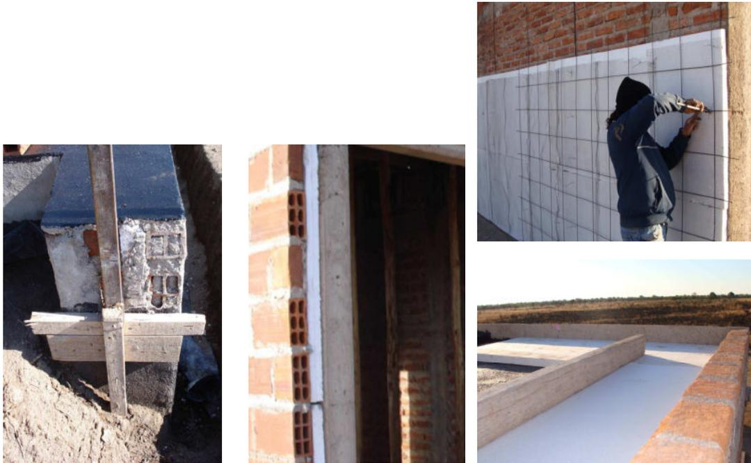
Fig. 5: Aislamiento térmico en envolvente. Protección mecánica sobre aislamiento térmico en pared este: revoque sobre metal desplegado que no fue la especificada por los proyectistas en el pliego de licitación (centro), y en pared oeste, con ladrillo cerámico (derecha).
