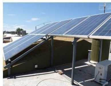
Vista del Techo
