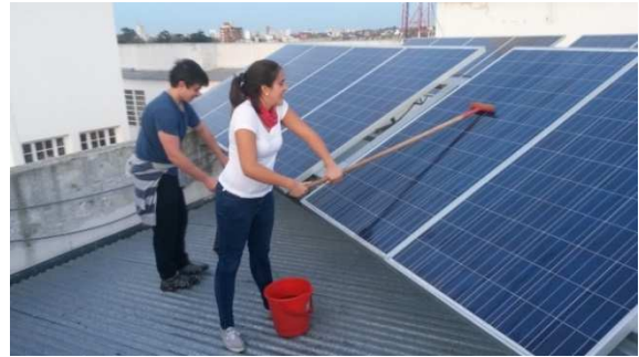
Fig. 7: Proceso de limpieza
