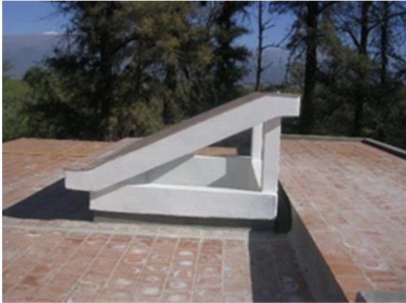
Foto 2.- Terminación techo modificado
