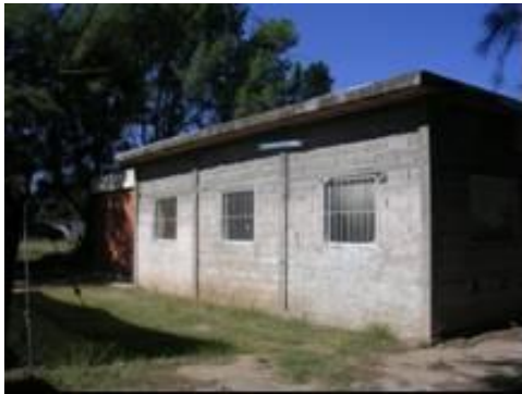
Foto 3.- Ventanas de la sala de lavado orientadas hacia el Norte.
