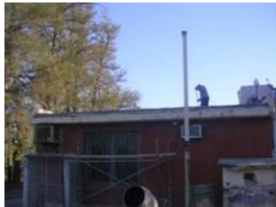
Foto 1.- Construcción techo con aislación
