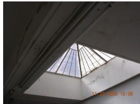
Foto 4.- Lucernario de la sala de lavado.
