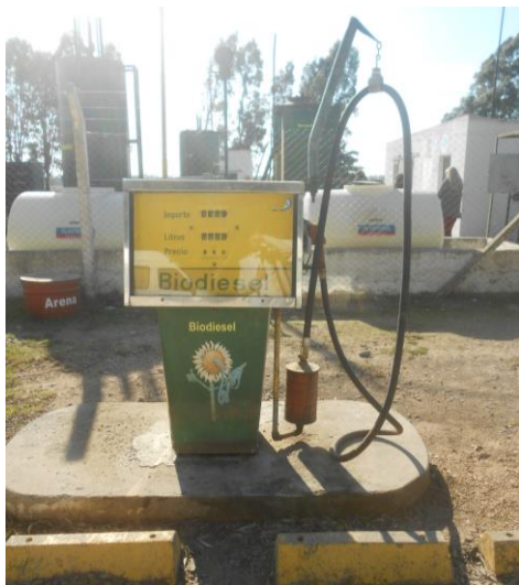
Fig. 2: Surtidor de la planta de biodiesel de la EATA
