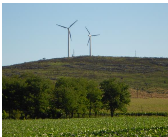
Fig. 1: Parque eólico CRETAL en la localidad de Tandil
