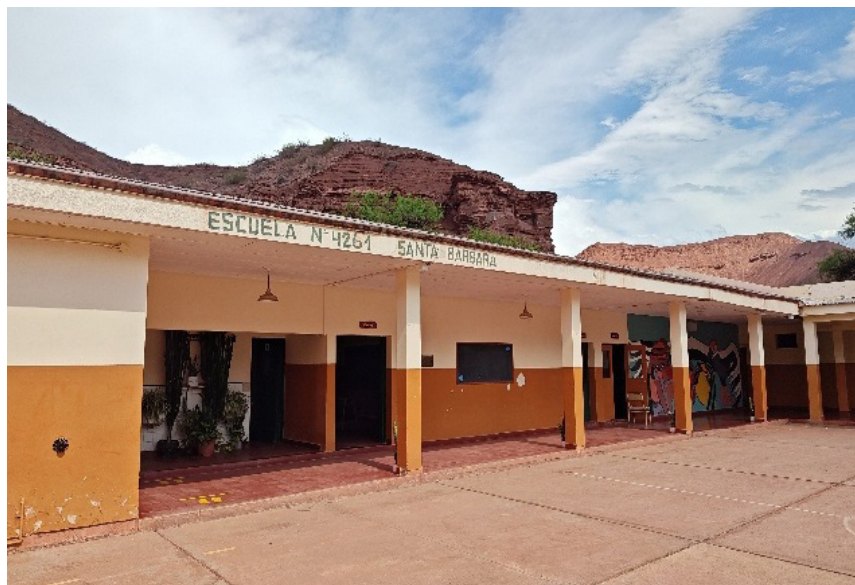
Figura 1: Escuela Rural de Santa Bárbara. Fuente: banco propio de imágenes.
