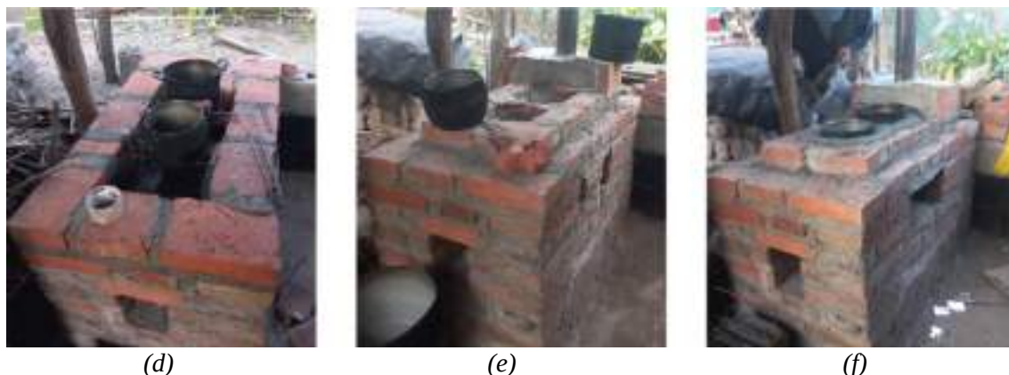
Figura 2: Proceso de construcción de prototipo de Cocina Martina, (a) cimientos, (b) base, (c) trampa de ceniza y base de la cámara de combustión, (d) definición de ubicación de ollas dentro de la cámara de combustión, (e) construcción de hornallas y colocación de chimenea, (f) detalles finales.
