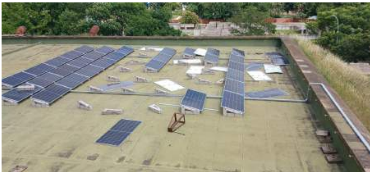
Figura 4. Estado del ala oeste del sistema de 50 kW (Edificio 42, CAC) consecuencia del temporal del día 17/12/2023.
