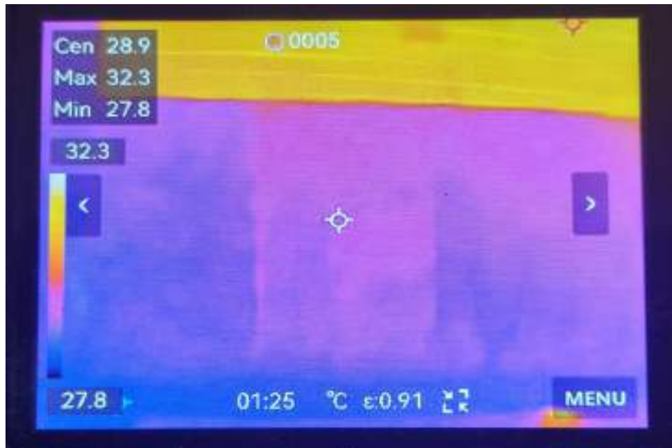
Figura 6. Imagen termográfica tomada in situ. Elaboracion Propia.
