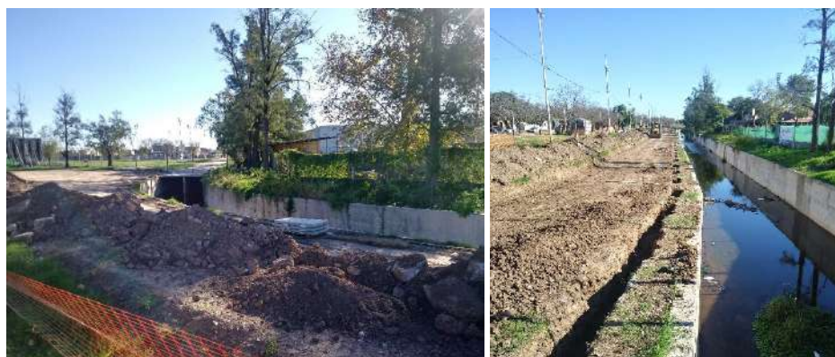
Figura 4: Obra de entubado tipo cajón y revestimiento del Canal Sur en el tramo que atraviesa el predio del Club Sportivo Ben Hur, de la ciudad de Rafaela.
