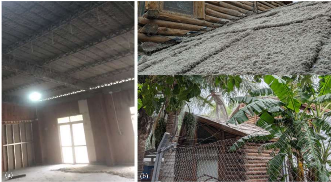
Figura 6: Aplicación de aislante de celulosa, Salón cultural (a) y cabaña (b). Fuente: E. P.
