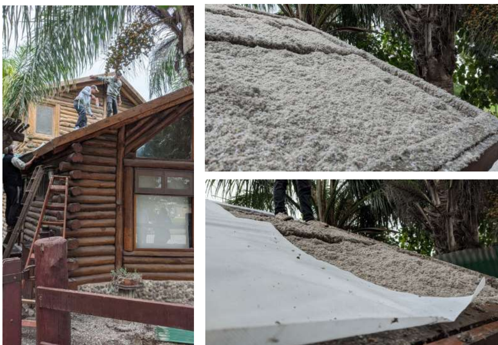
Figura 9: Proceso de colocación de celulosa en cubierta y lámina de membrana aislante hidrófuga. Fuente: E.P.
