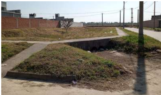
Figura 7: Inadecuado funcionamiento del desagüe pluvial urbano por falta de resolución.
