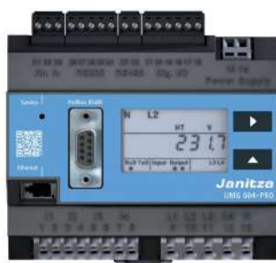
Figura 4: Medidor de energía eléctrica Marca Janitza ya instalado en la central fotovoltaica.
