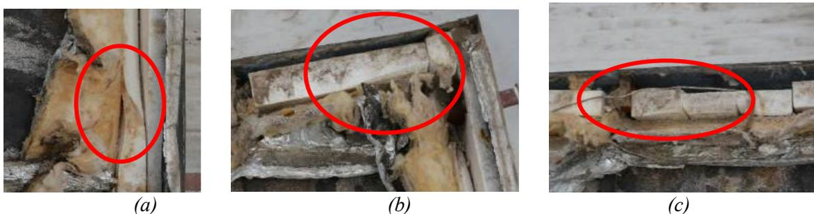
Figura 7: CAI oval (a) (b) y (c) Vista de la degradación térmica del poliestireno expandido.
