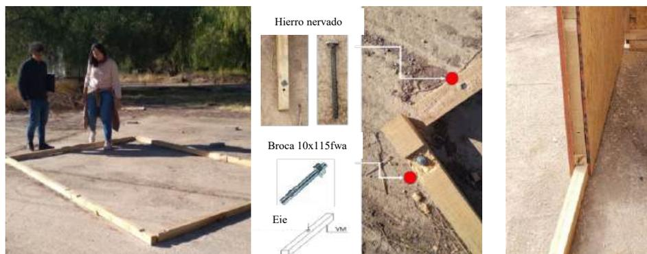
**Figura 6.** Replanteo y anclaje tabiques verticales a fundaciones.
