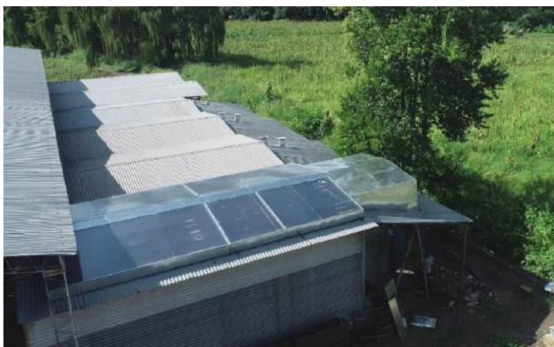
Figura 6: Fotografía aérea del sistema propuesto ya instalado en los techos de la estufa. Calentadores solares y envoltura a la unidad de calor.
