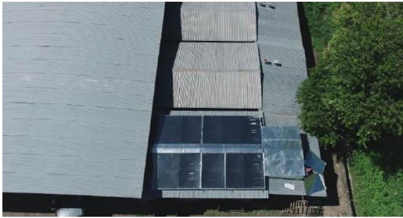
Figura 7: Vista en planta del sistema de precalentamiento de aire instalado.
