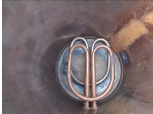
Figura 2: Sistema de calentamiento con resistencias de ACS
