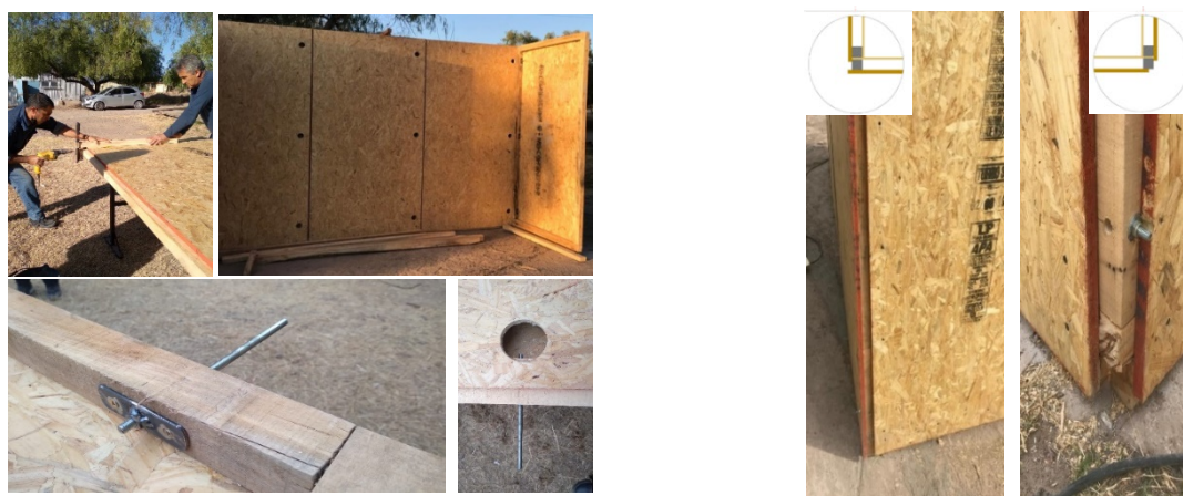
Figura 7. Armado de paneles
