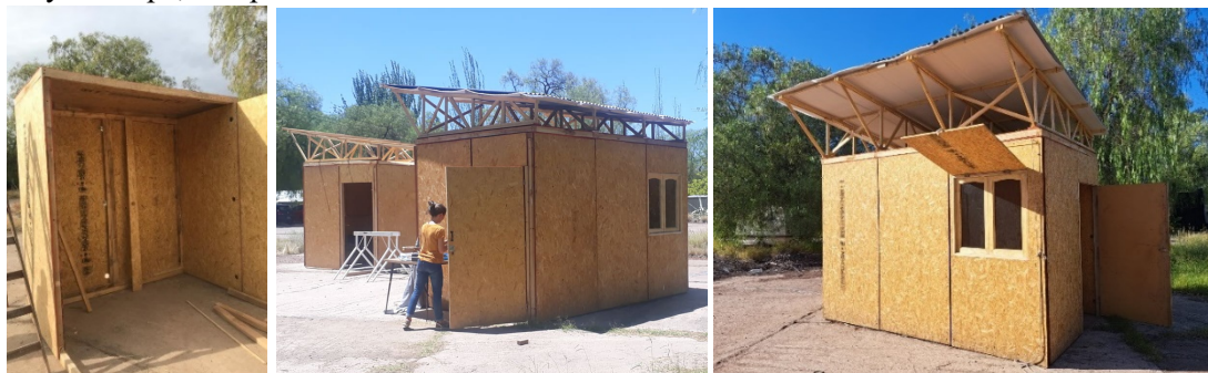
Figura 8. Encuentro de paneles verticales con el techo y habitáculos terminados
