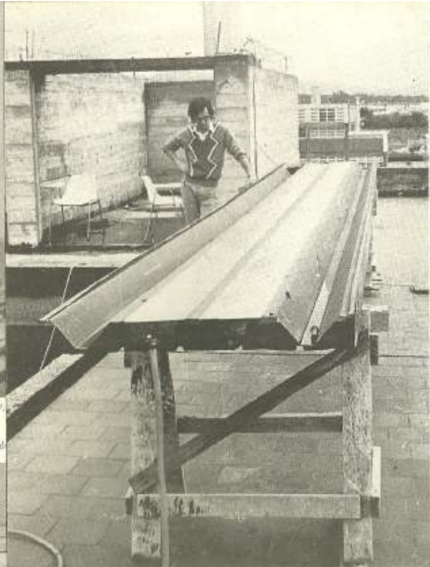
(IV. 4) Calentador de agua construido sobre techos prefabricados.
