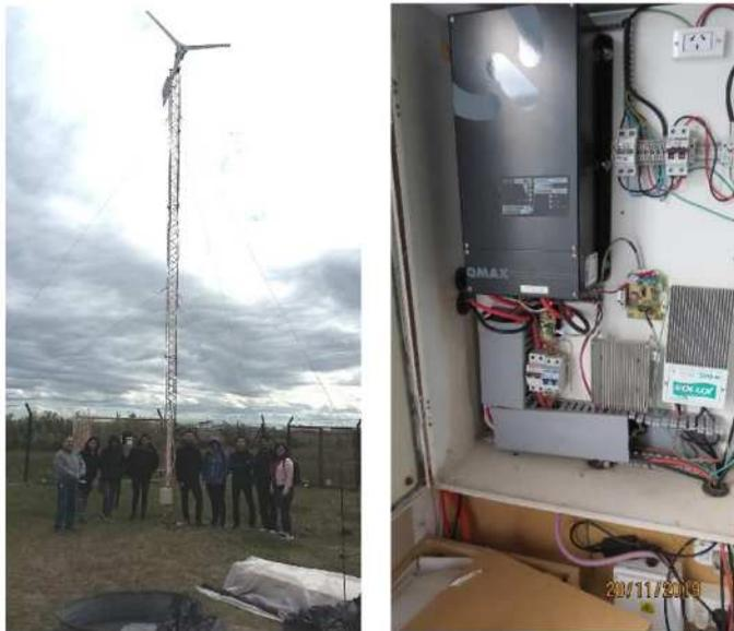
Figura 11: Prácticas en Sistema demostrativo Campus UARG con cohorte 2019 (izq) de Materia Energías Renovables, y vista del sistema inversor/regulador (der)
