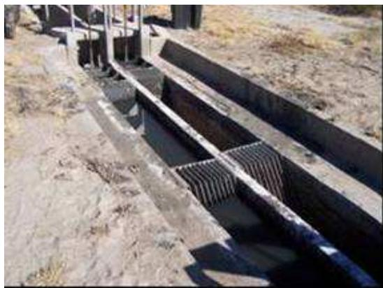
Figura 3. Cámara de rejas del sistema de lagunas de estabilización de la ciudad de Andalgalá.
