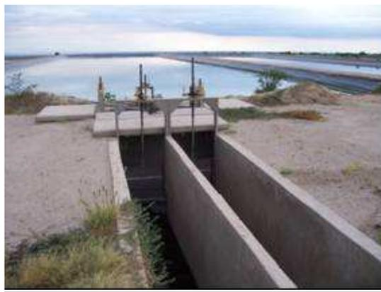
Figura 4. Desarenador del sistema de lagunas de estabilización. Sitio de muestreo.
