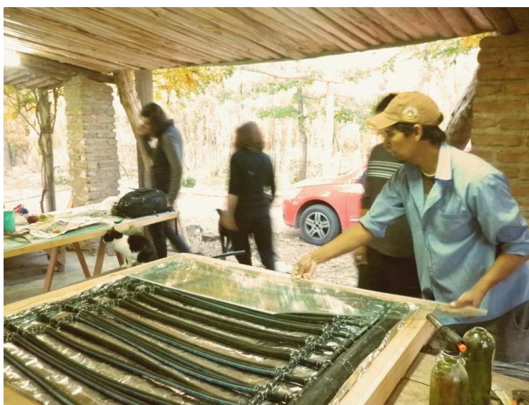
Fig. 9 Pobladores durante la construcción de los colectores con material de rezago
