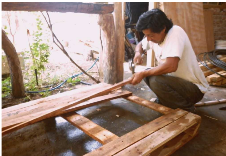
Fig. 8 Recuperación de pallets para el armazón de los colectores
