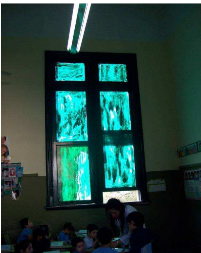
Figura 1: ventanas pintadas para sacar la luz del campo de visión
