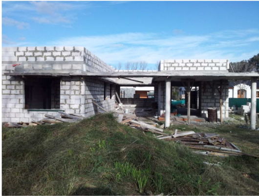
Figura 4: Fachada Norte en ejecución
