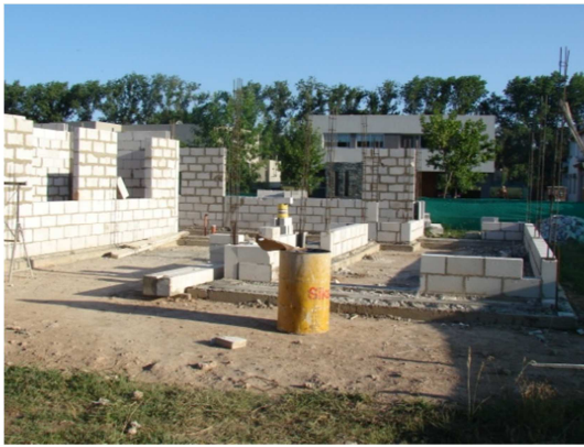
Figura 2: Etapa de elevación de muros
