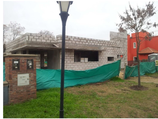
Figura 3: Fachada Sur sobre calle pública en ejecución
