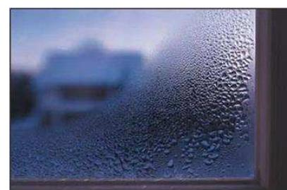
Foto 1,2 y 3. Registro de condensación superficial interior tanto en los perfiles como en el paño vidriado de una vivienda unifamiliar
