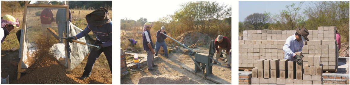
Figura 6. A la izquierda: Taller desarrollado en el terreno, destinado a obreros que trabajaron en la producción de bloques para el prototipo. A la derecha: Bloques producidos para el prototipo
