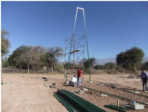
Figura 12: Colocación de los pórticos de la estructura del absorbedor
