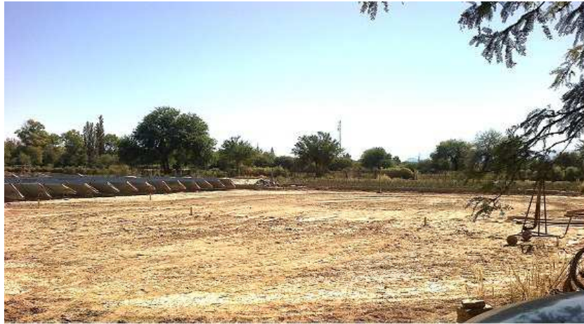
Figura 10: Vista del terreno donde se construye el CFL
