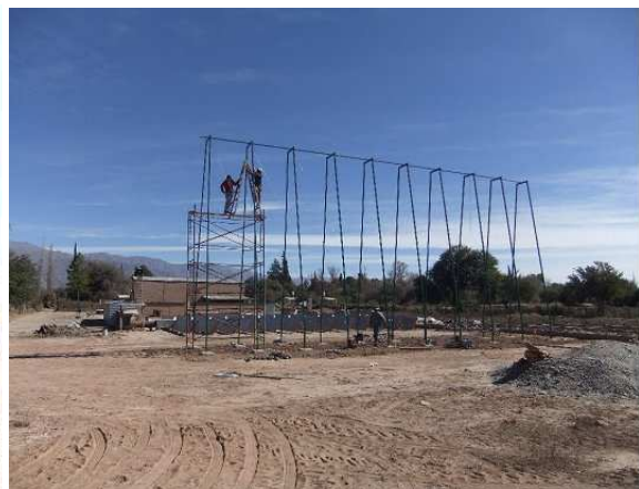
Figura 12: Colocación de los pórticos de la estructura del absorbedor
