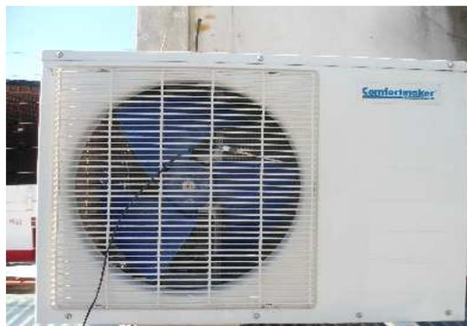
Figura 2: Foto del condensador y termocupla tipo K
