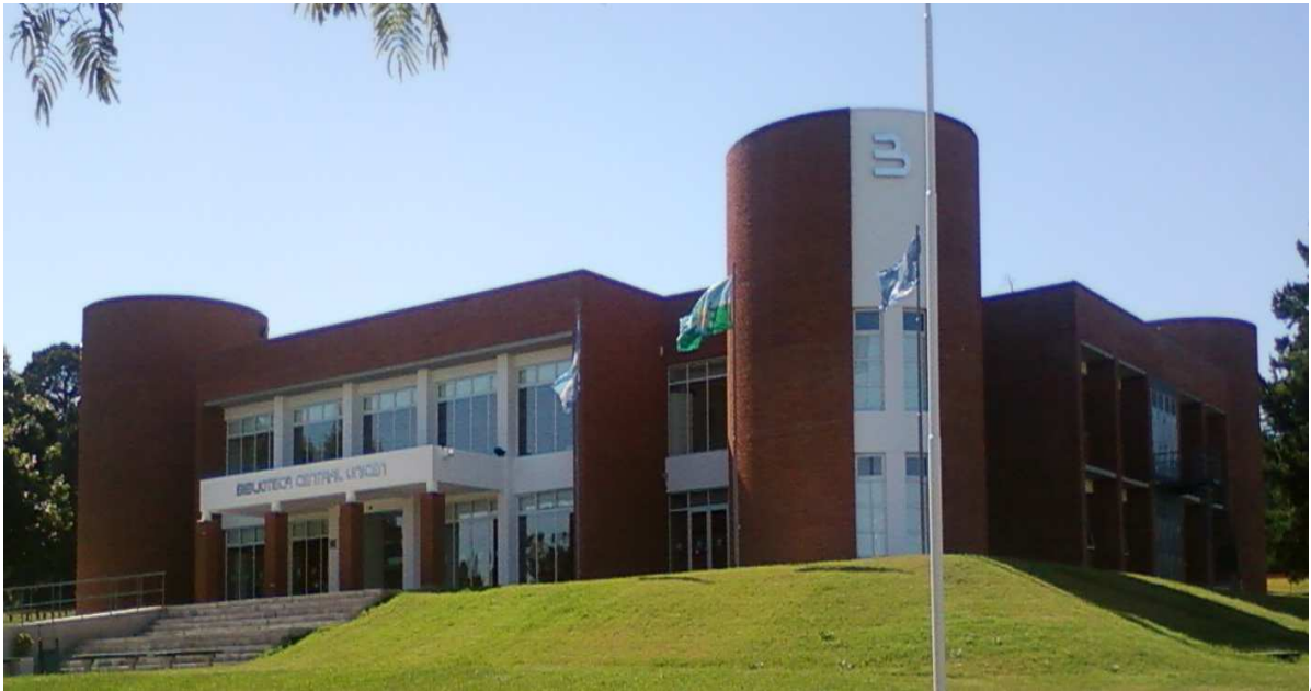
Figura 1: Vista al noroeste del edificio evaluado.
