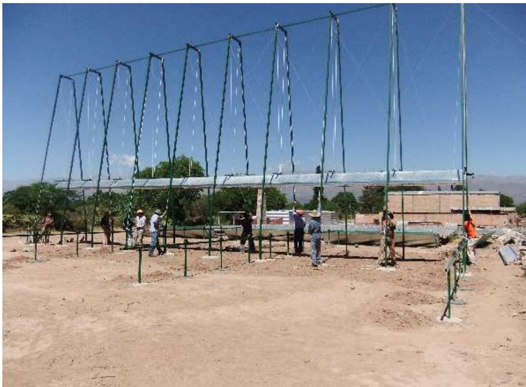
Figura 7: Subida de los absorbedores mediante poleas que los sostienen desde la parte superior de la estructura
