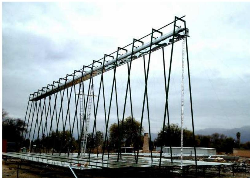
Figura 2.- Vista general del generador mostrando las ocho líneas de espejos de 24 m de largo y el absorbedor de 30 m.
