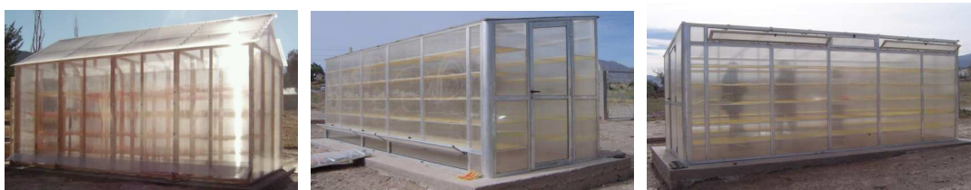
Figura 5: secadores solares construidos en Valles Calchaquíes en madera o aluminio.
