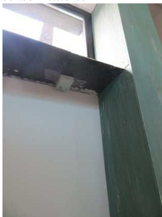
Figura 8. Colocación del sensor, visto desde abajo.
