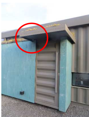
Figura 4. Puerta de entrada
