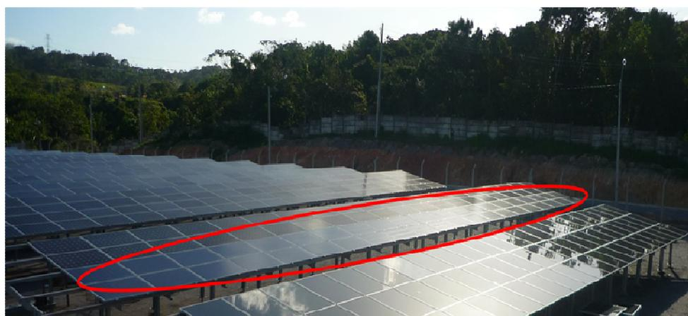
Figura 2. Sistema fotovoltaico de silício policristalino.
