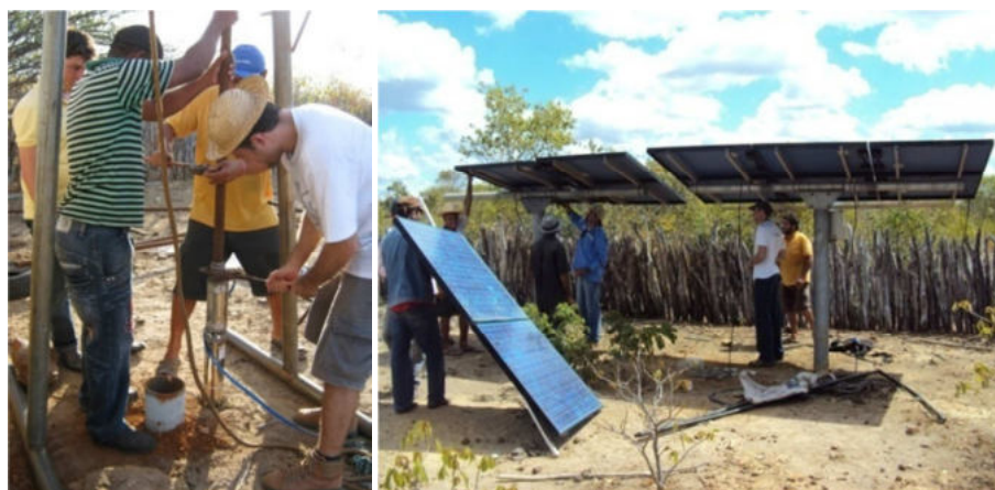
Figura 4: Processo instalação da motobomba e instalação dos módulos fotovoltaicos com participação da comunidade.
