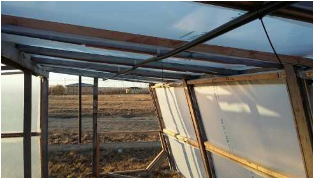
Figura 9: Interior del Invernadero, tendido de cañerías de riego y revestimiento
