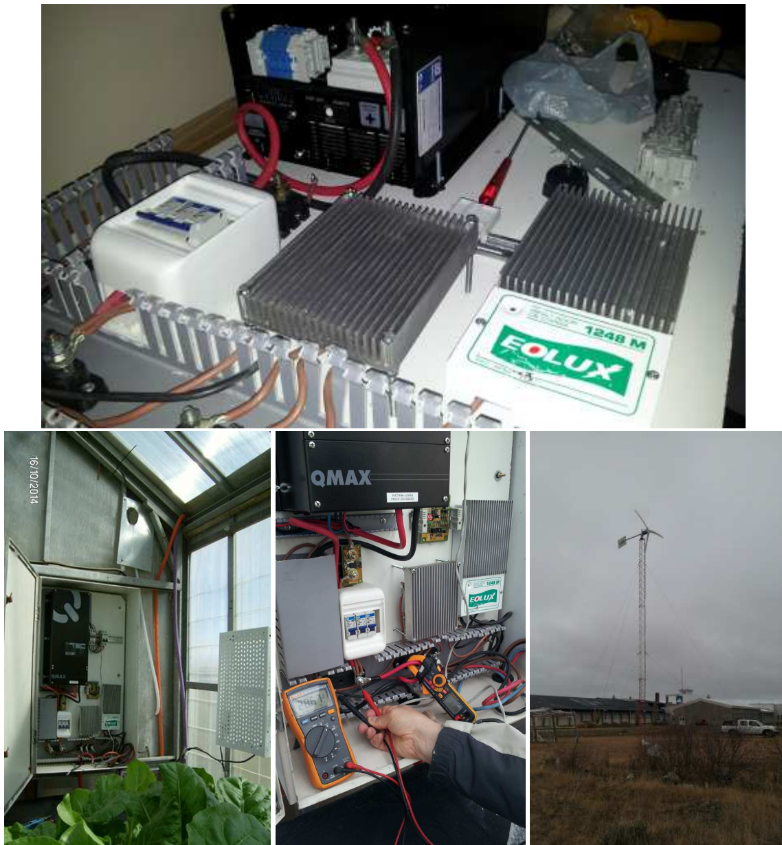
Figura 2: Armado del tablero (arriba) e instalación transitoria inicial del sistema 2014/15
