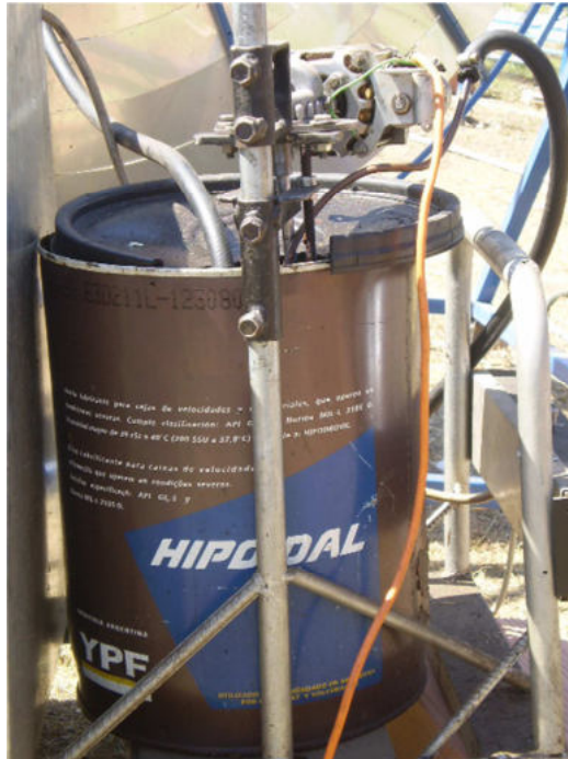
Figura 3. Sistema de almacenamiento y circulación del aceite
