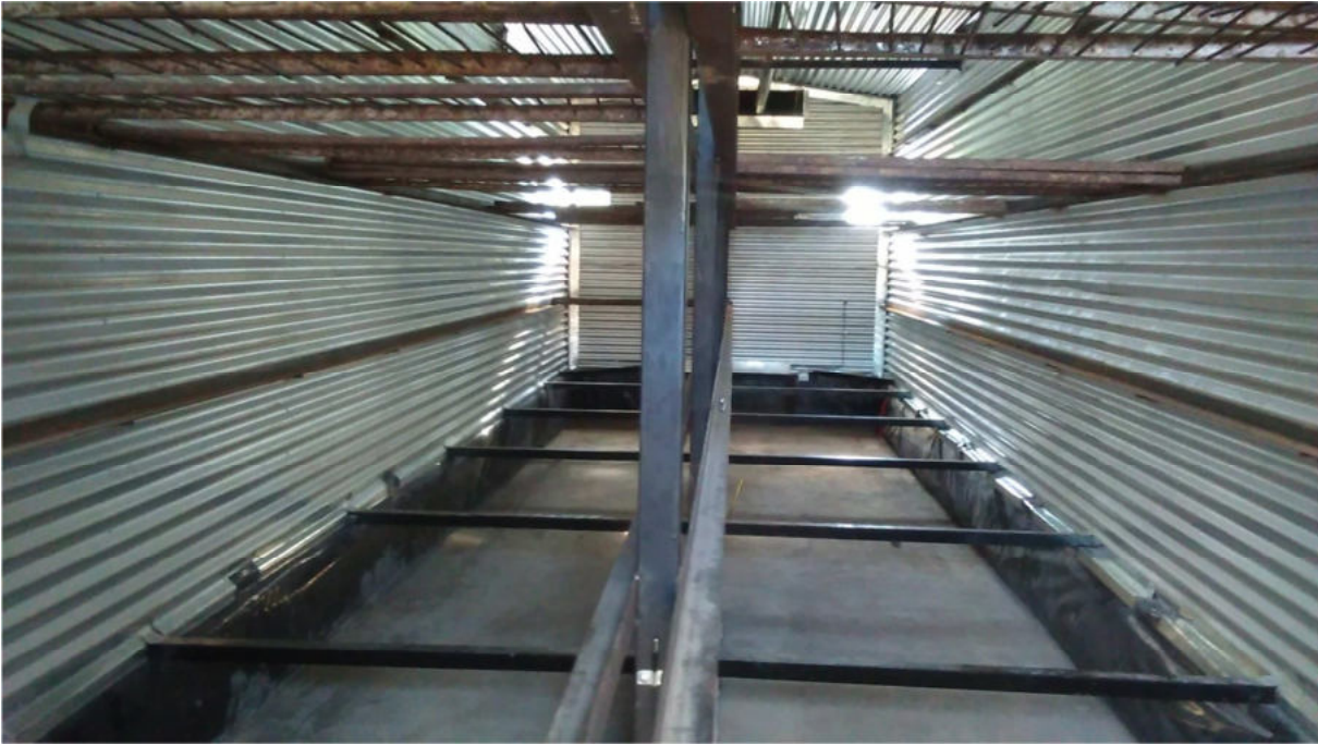
Figura3: Etapa constructiva del interior. Se observa el piso de cemento con losa radiante por abajo y el aislamiento en las paredes perimetrales.
