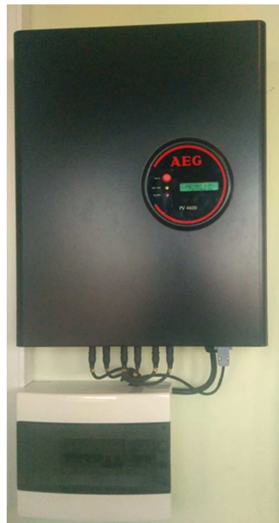
Figura 2: Inversor AEG.
