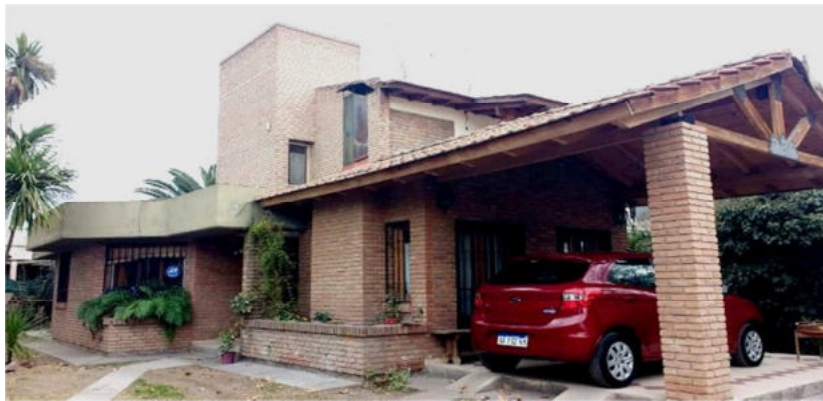
Figura 11: vivienda tradicional construida en ladrillo visto. Se observa la construcción en PB con techo horizontal e liviano inclinado y parte de la construcción en PA.
