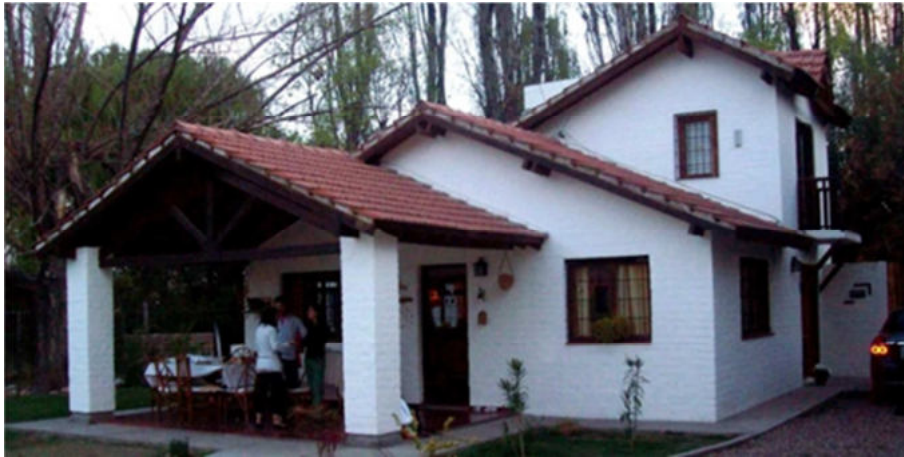
Figura 5: imágenes de la galería abierta y del resto de la fachada N de la misma. Se observa que parte del estar y del dormitorio en PA posee exposición al N.
