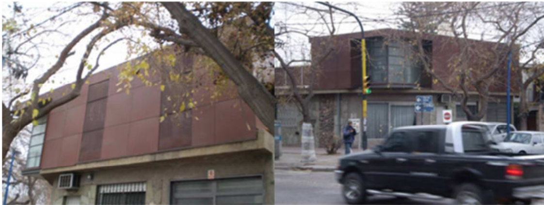
Figura 9: vivienda de construcción tradicional en ladrillo hueco. Izq. se observa la galería sobre fachada Este; der. se observa el frente N de los dormitorios.
