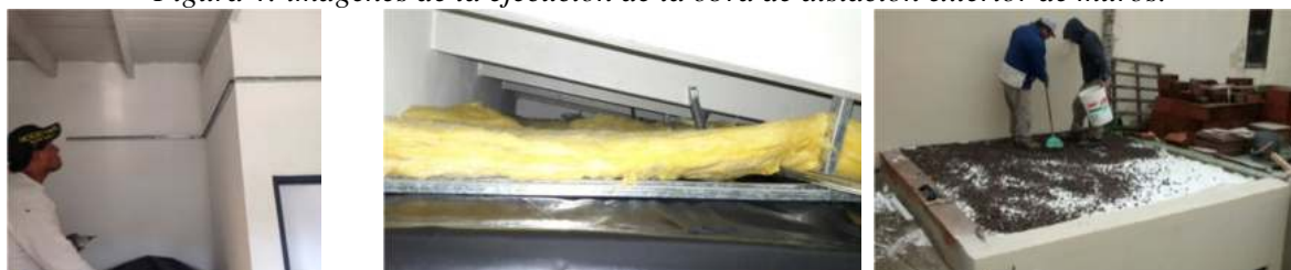
Figura 5: ejecución del cielorraso suspendido (izq.) y de la aislación térmica de la losa (der.)
