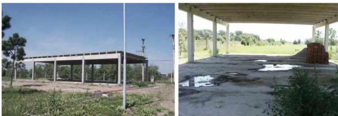
Figura 1a y b: Estructura existente para la construcción del edificio de talleres de investigación UNVM.
