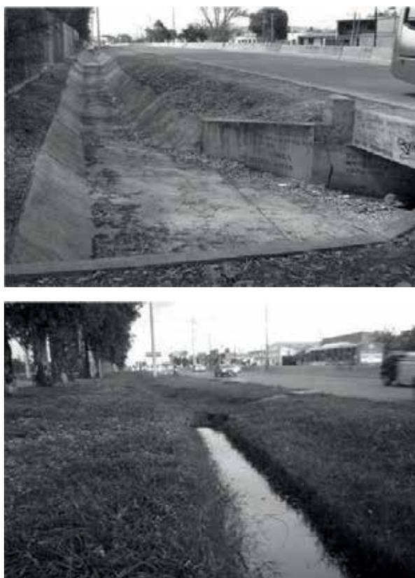
Fig. 2: Ambientes de tipo A: canalizaciones a cielo abierto con sustrato de hormigón (izquierda) y B: bajos inundables, banquetas y canalizaciones con vegetación o suelo desnudo (derecha)
