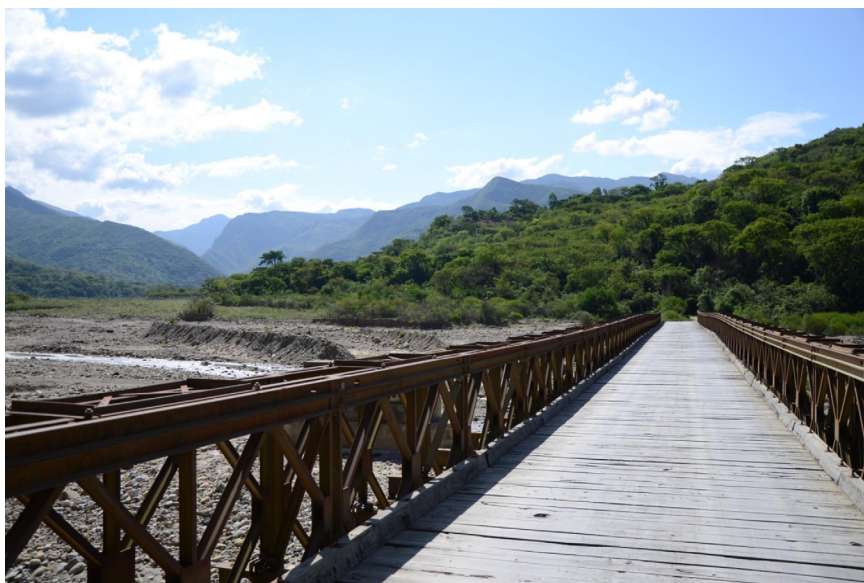
Figura 8. Puente Bailey actualmente en uso.
