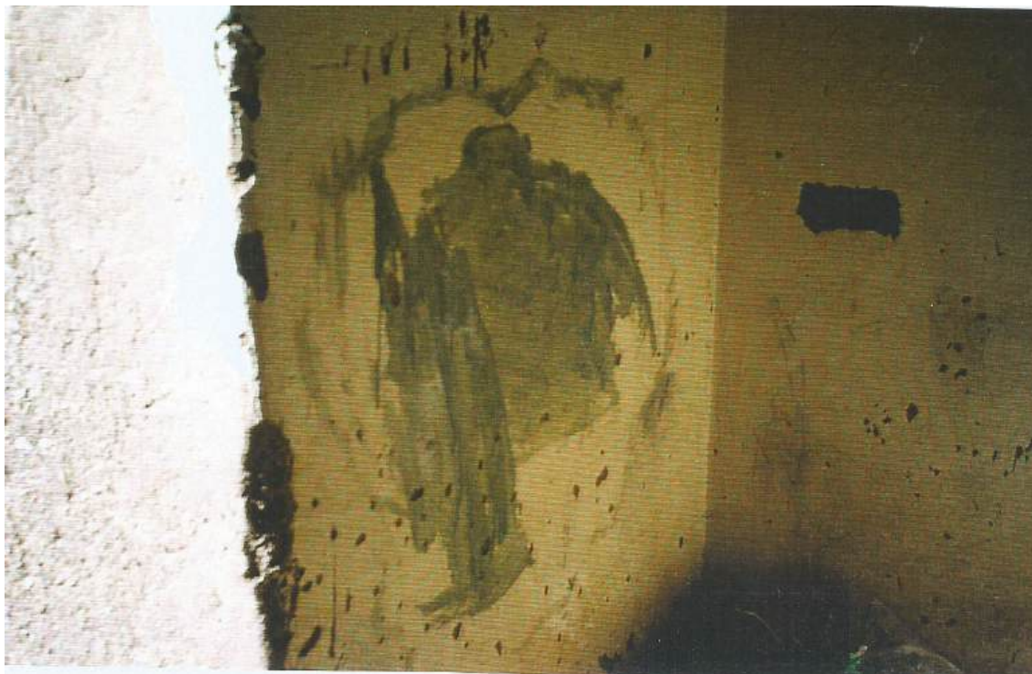
Figura 5. Pintura en otra de las paredes de la parte hermética o antecapilla.
